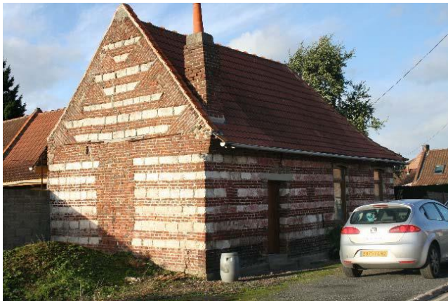
Exemples de mur « rouges barres »
