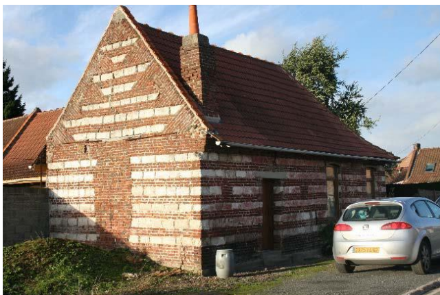
Exemples de mur « rouges barres »
